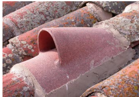
Entrées des nichoirs intérieurs Photo : P. Pilard
