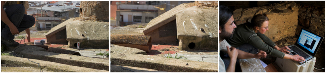
Proceso de instalación de la cámara web ( Fotos Pepe Antolín )
