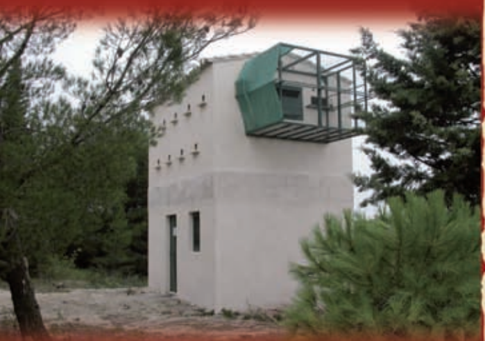
Bâtiment de libération dans l'Aude © Philippe Pilard
